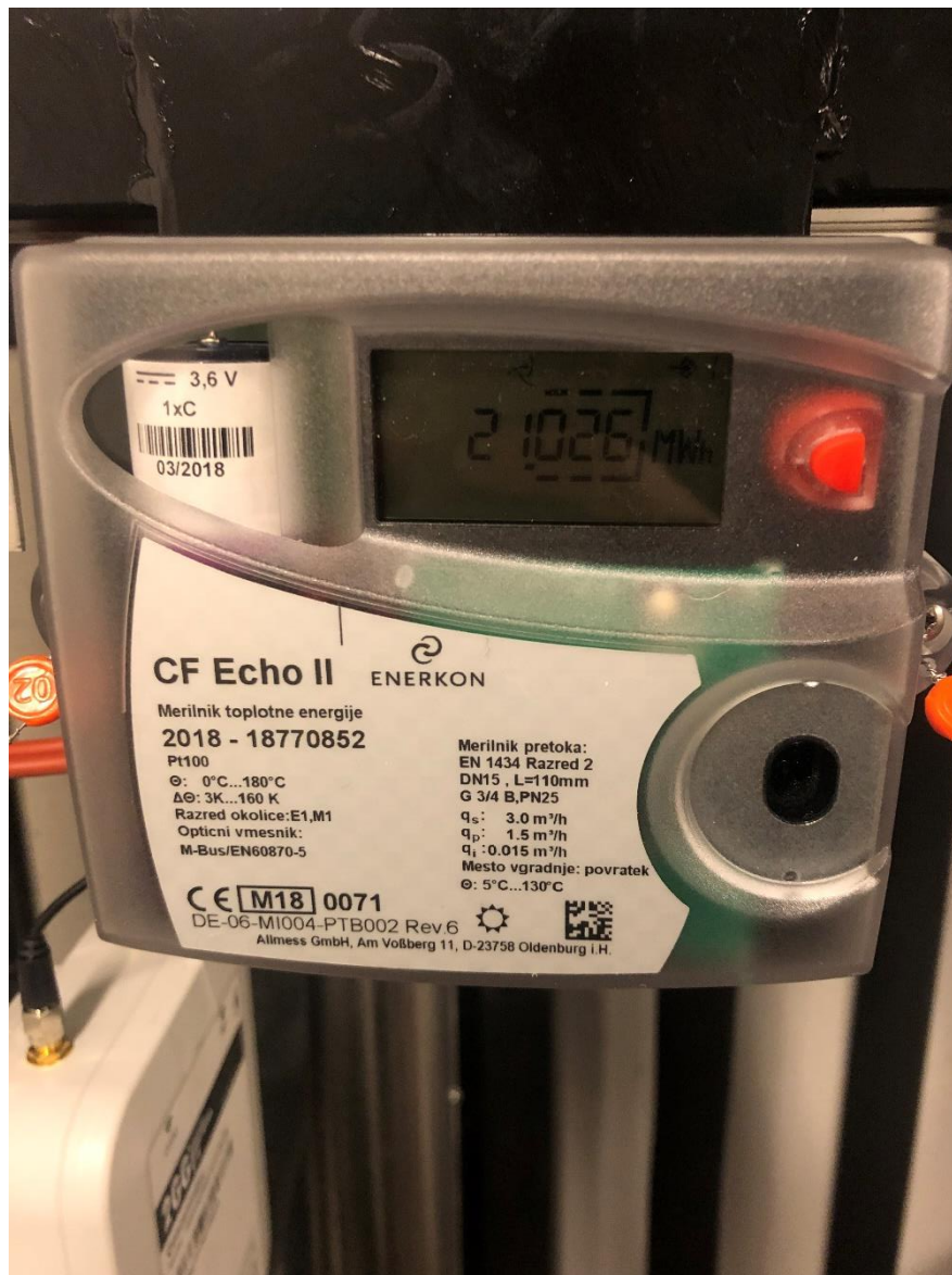
Priloga 8: Merilno mesto, števec pretoka in toplotne energije na vstopu v objekt
