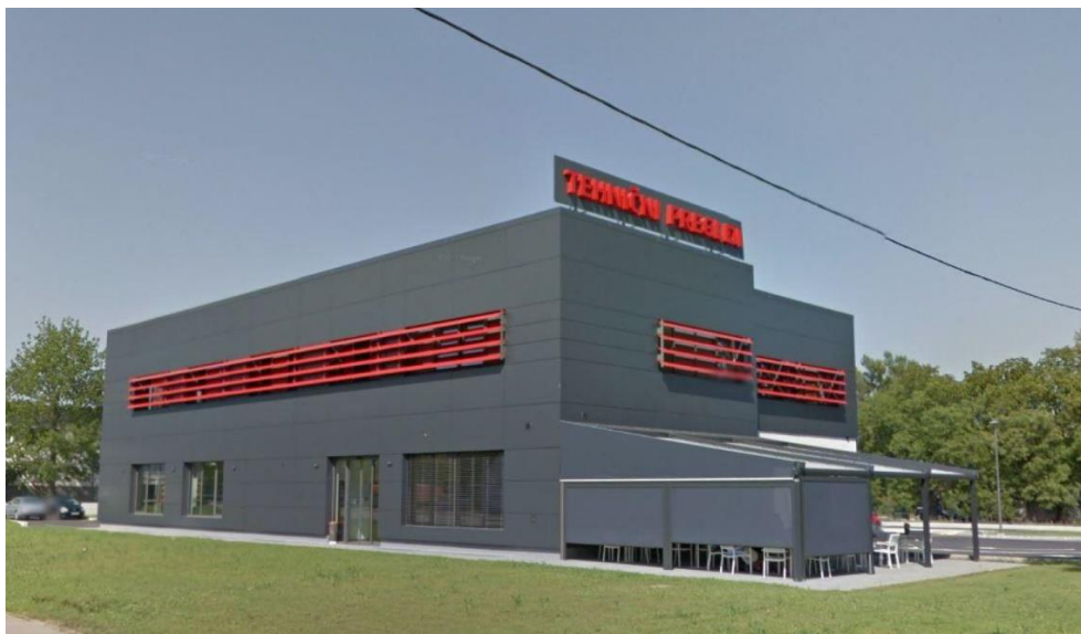
Slika 8: Obravnavana realna stavba, postavljena v Ljubljani (Lastni vir)
