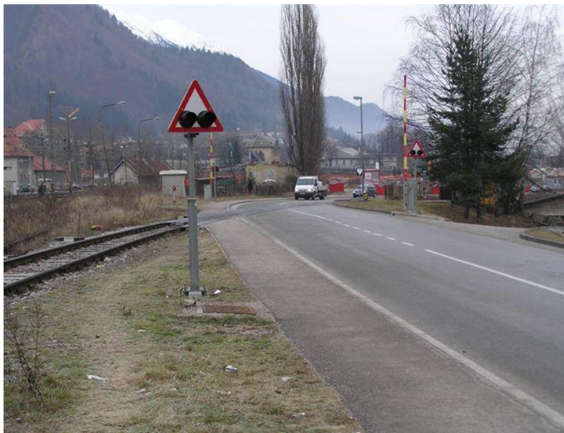
Slika 4: Zavarovan nivojski prehod na industrijskem tiru Acroni Vir: Damjana Nučič, 2008
