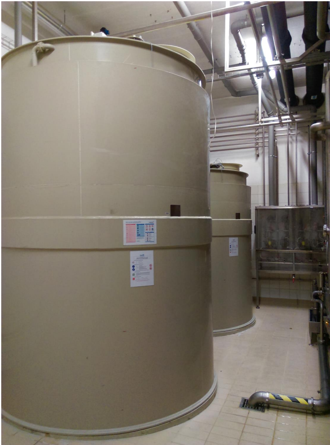
Slika 13: Nova rezervoarja za nevarne tekočine Rez18 in Rez19 (Lastni vir, 2017)
