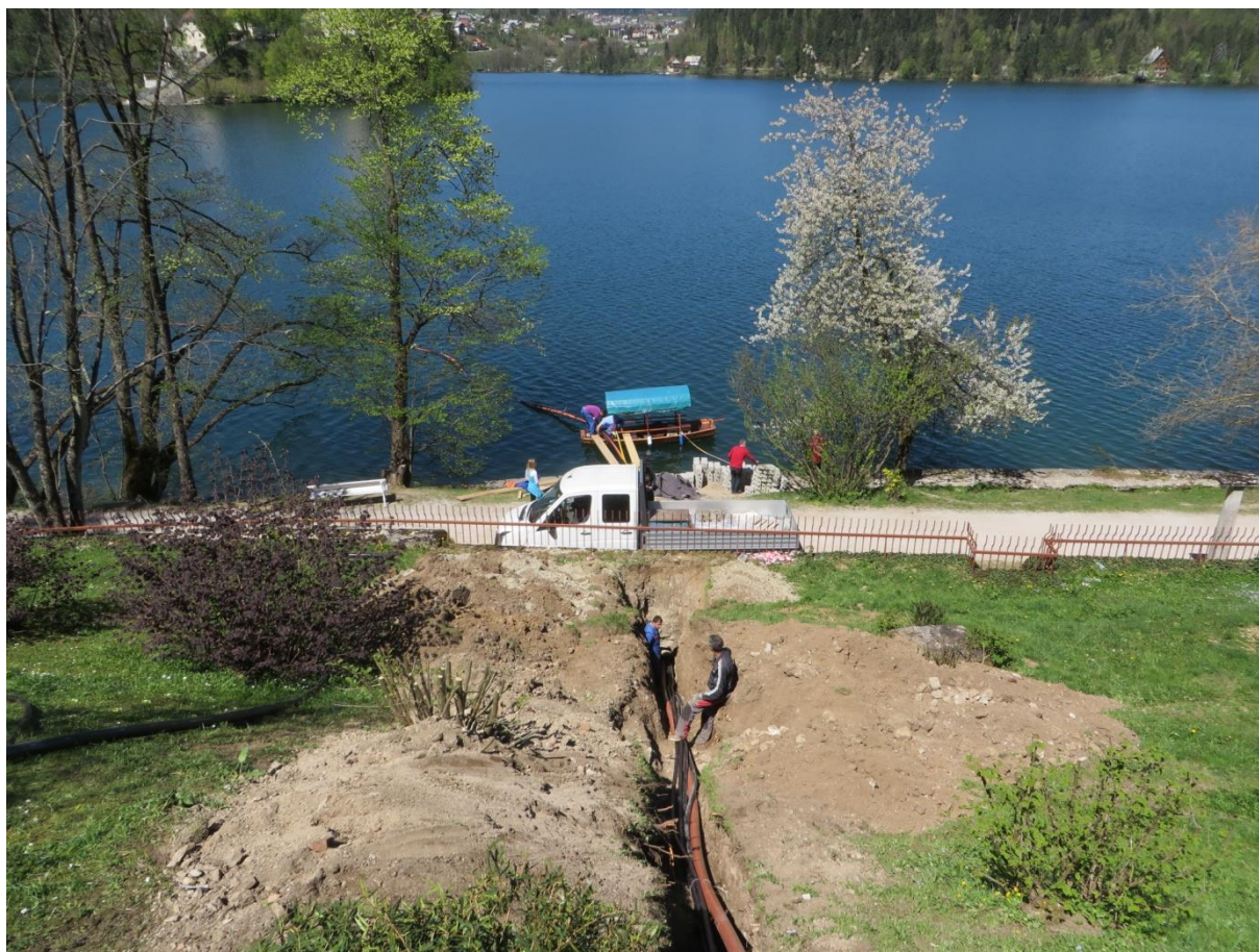
Slika 11: Polaganje kabla pri vstopu kablovoda v jezero (Vir: Elektro Gorenjska, 2016–2017)
