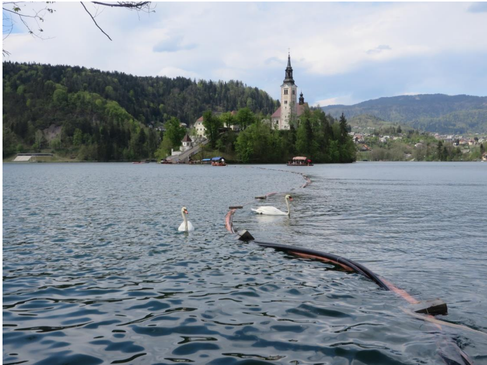
Slika 17: Razvlek kolektorja z električnim čolnom (Vir: Elektro Gorenjska, 2016–2017)
