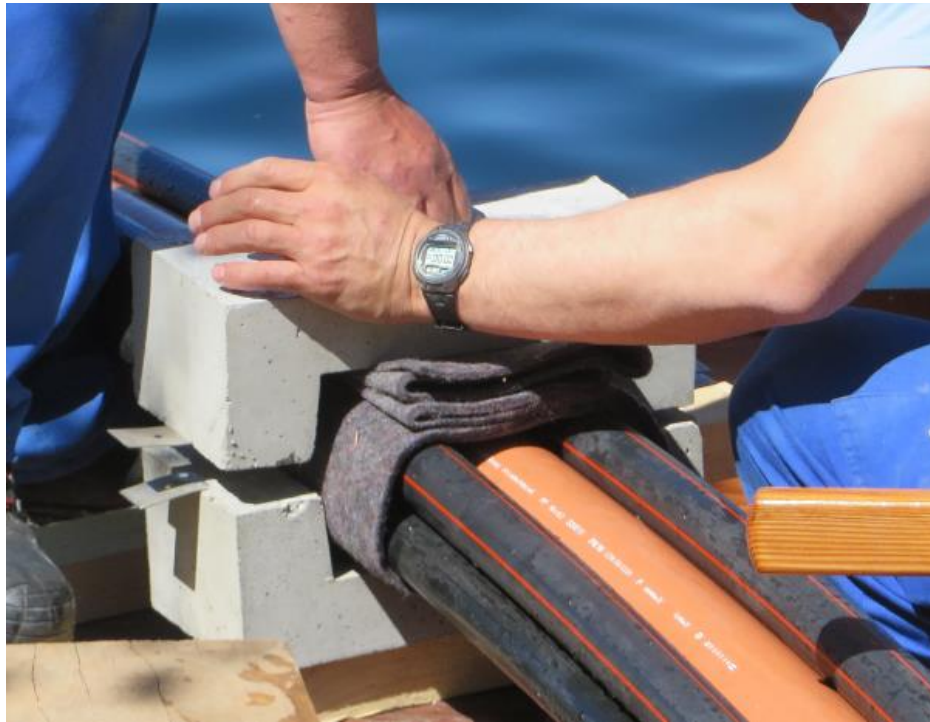
Slika 18: Sestavljena betonska utež (Vir: Elektro Gorenjska, 2016–2017)
