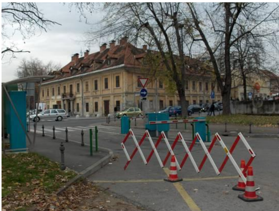
Fotografija 6: Pogled od zapornice JP na glavno (Njogoševo) cesto
