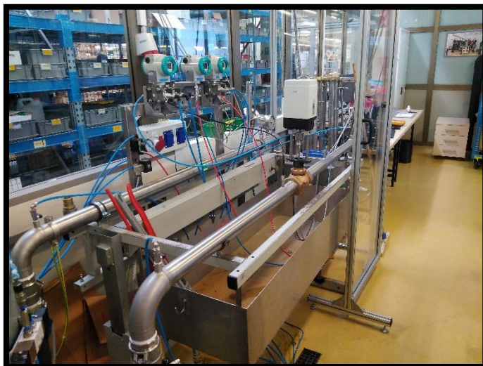
Slika 43: Montaža vzorca in cevi na testno progo (Lastni vir)
