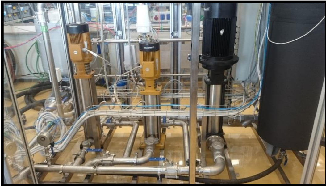
Slika 18: Vgradnja črpalke na testni progi (Lastni vir)
