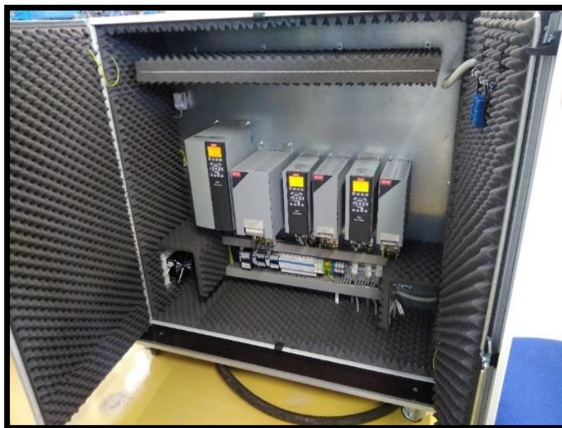
Slika 29: Frekvenčni pretvorniki v zvočno izolirani omari (Lastni vir)
