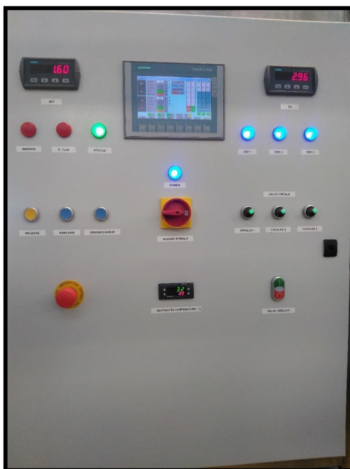
Slika 27: Sprednja stran krmilne elektro omare (Lastni vir)
