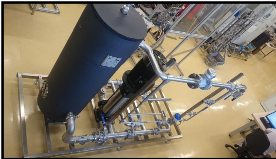
Slika 16: Montaža merilnikov pretoka na testno progo (Lastni vir)
