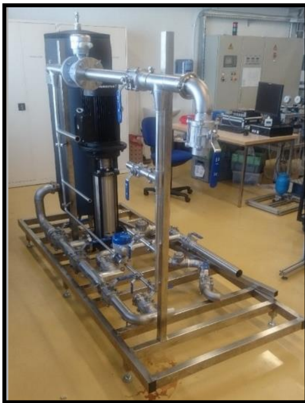
Slika 17: Izdelava cevnih povezav za vzporedno in zaporedno vezavo črpalk (Lastni vir)
