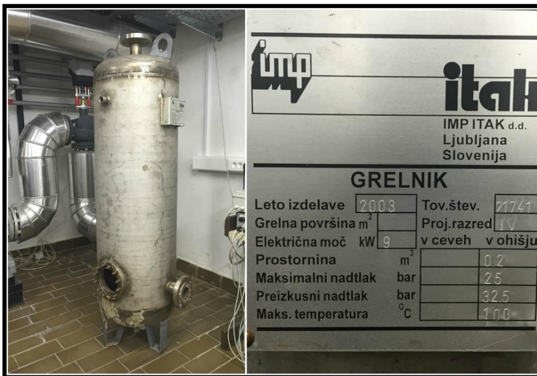
Slika 8: Tlačna posoda s tablico in opravljenim tlačnim preizkusom (Lastni vir)
