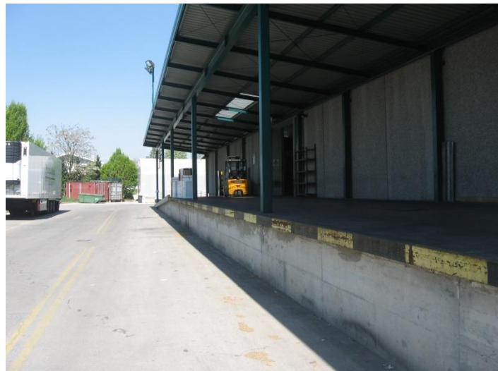
Slika 10: Rampa (Vir: lasten)
