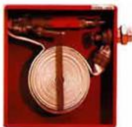
Slika 15: Mokri notranji hidrant
