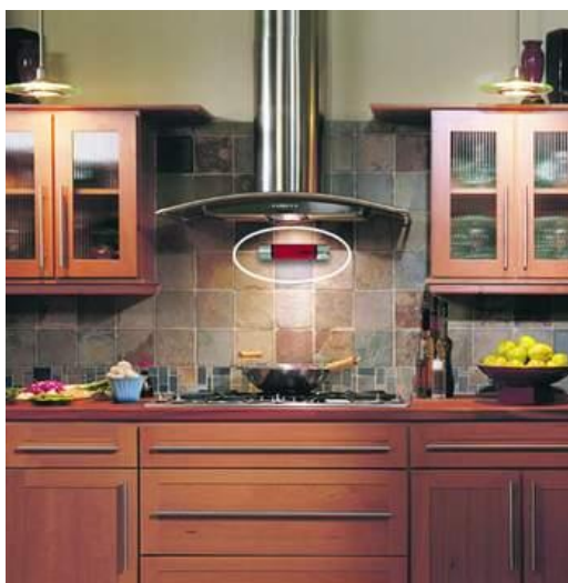
Slika 8: Gasilna ampula, nameščena pod kuhinjsko napo
