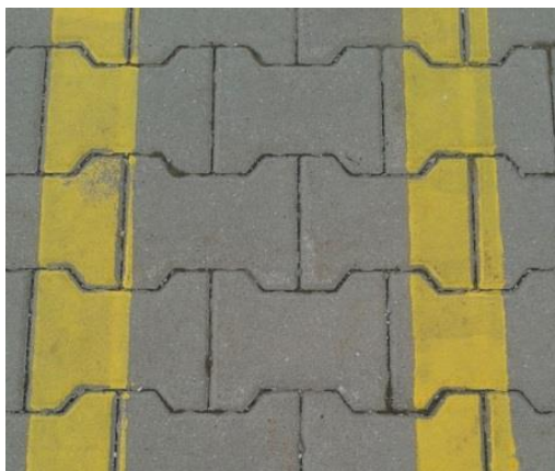
Slika 27: Fuge na peronu (Vir: Lasten)
