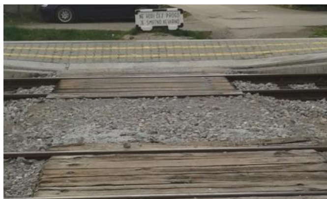
Slika 34: Prehod na peron (Vir: Lasten)
