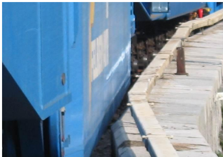
Slika 20: Vožnja izredne pošiljke mimo ograje Jelenovega viadukta Vir: Slovenske železnice, d. o. o., 2012
