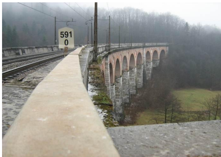
Slika 19: Jelenov viadukt pri Borovnici Vir: http://www.vlaki.info/forum/vewtopic.php .
