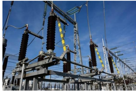
Slika 7: Ločilnik z ozemljitvenimi noži, 110 kV (Lastni vir)
