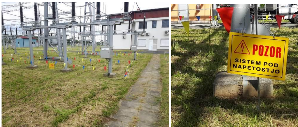
Slika 16: Ograjevanje in označitev mesta dela od delov, ki so pod napetostjo (Lastni vir)
