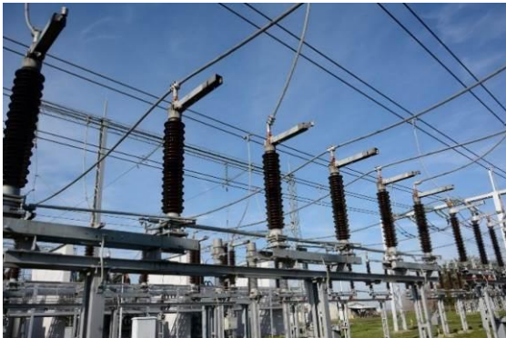
Slika 6: Sistemski ločilnik, 110 kV (Lastni vir)
