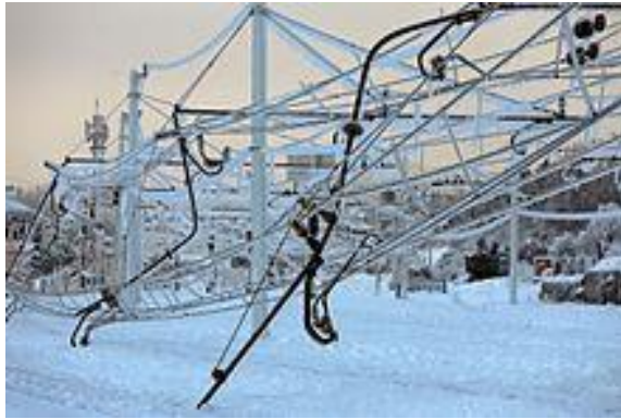
Slika 23: Polomljeni električni napajalni drogovi 2014 Postojna (Vir: https://sl.wikipedia.org/wiki/Žled , (22.06.2019))
