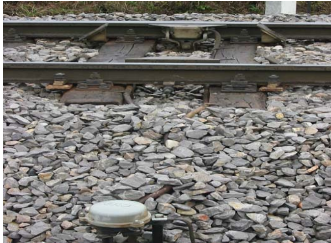
Slika 37: Naprava za štetje osi.
