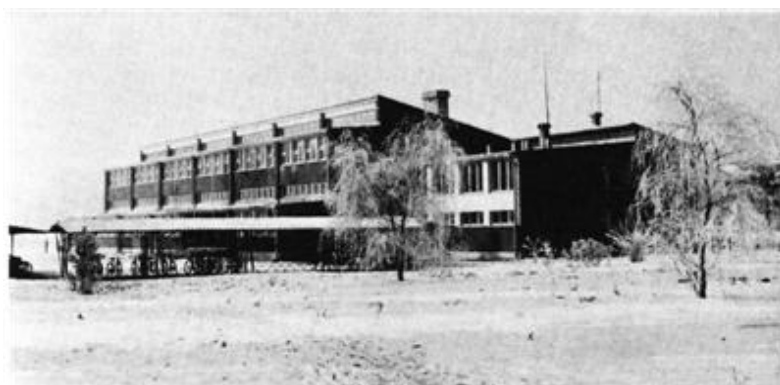
Slika 2: Šola – še brez prizidka
