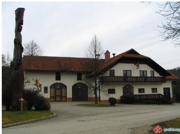
Slika 1: Gasilski dom in dvorana PGD Žeje - Sv. Trojica (Vir: www.gasilci.org , 18. 3. 2016)
