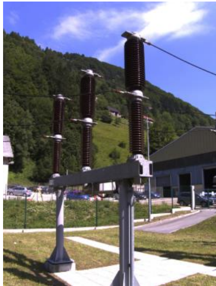
Slika 6: Primer odklopnika Eles. (b.l.)
