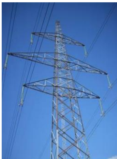
Slika 3: Primer najpogosteje uporabljenega tipa daljnovoda - dvosistemski daljnovod Inštitut za neionizirana sevanja (b.l.)
