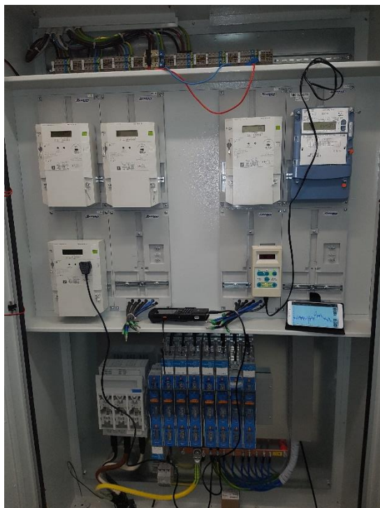
Slika 22: Priključna omarica na Bledu, prikaz poteka meritev Lastna slika (b.l.)
