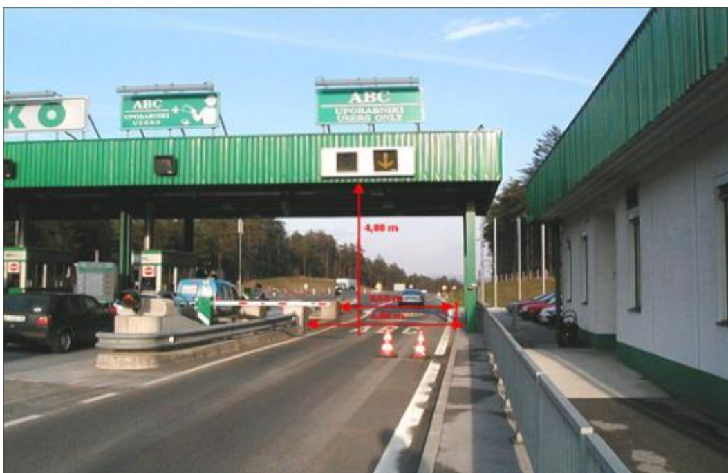
Slika 16: Dimenzije ( V (max) = 4,80 m, \check{S} (max) = 4,80 m) ABC-steze cestninske postaje Vransko (Vir: lastni)
