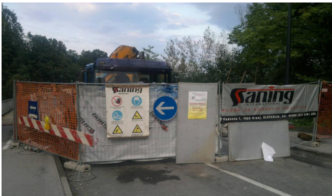
Slika 19: Gradbišče iz smeri Ljubljana–Črnuče (Lastni vir)
