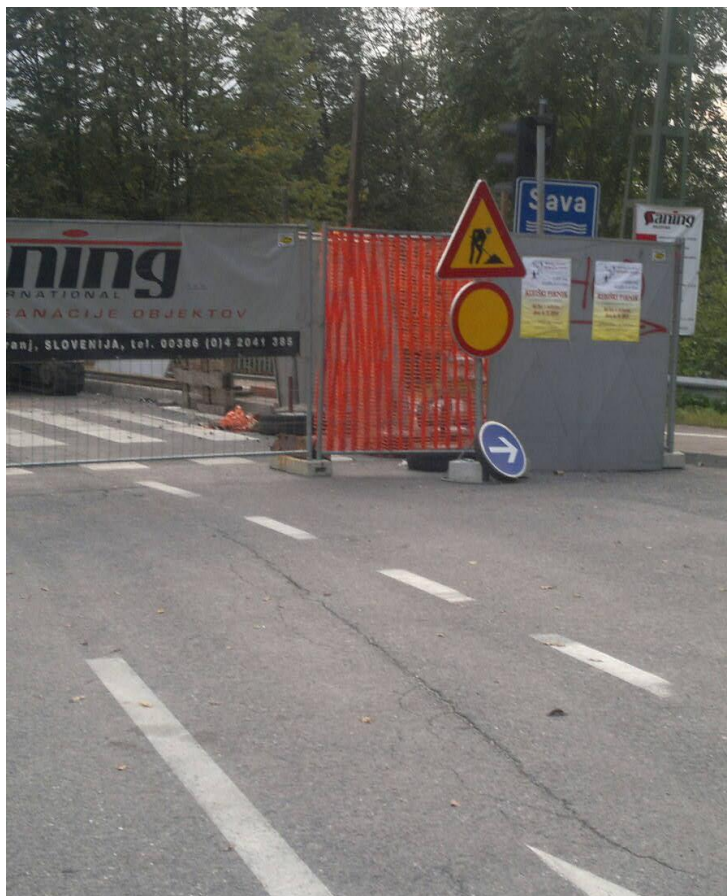
Slika 15: Gradbišče iz smeri Črnuče–Ljubljana (Lastni vir)
