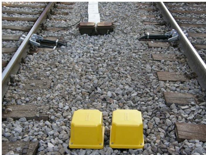
Slika 14: Elektronski kontakt števca osi
