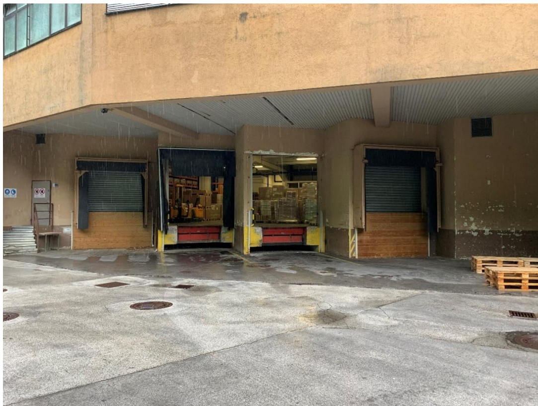
Slika 8: Kotne manipulativne ploščadi v Domelu (Vir: Lasten)
