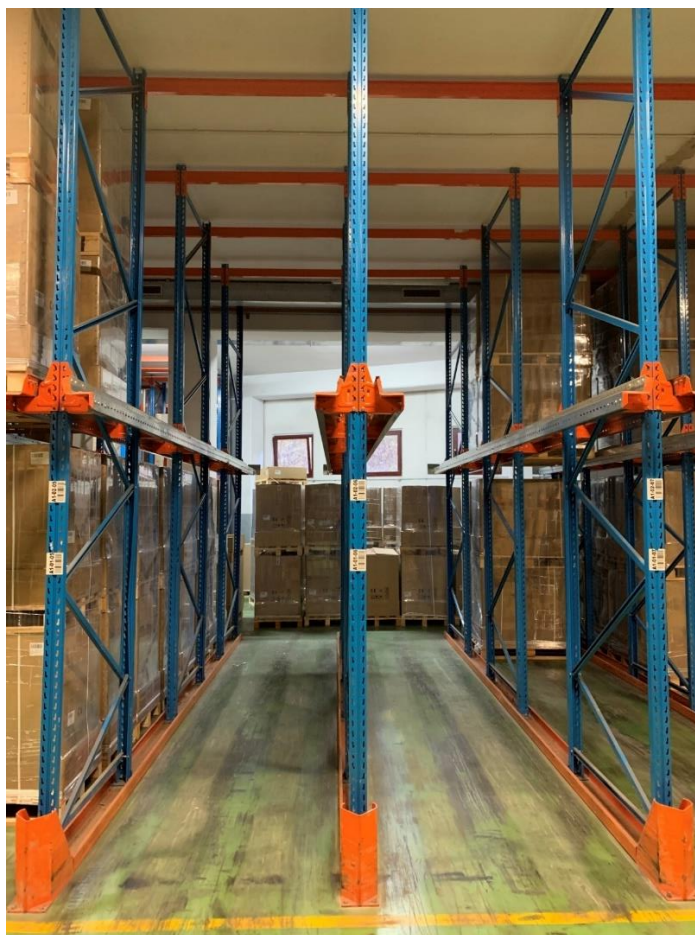
Slika 6: Stebrni regal z možnostjo preureditve v pretočnega (Vir: Lasten)
