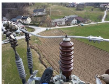
Slika 2 AL-FE goli vodnik 70 \text{ mm}^2 Lastni vir
