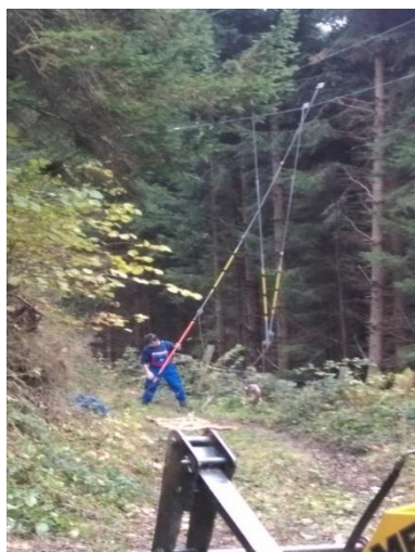
Slika 23 Nameščanje ozemljitvene naprave na DV
