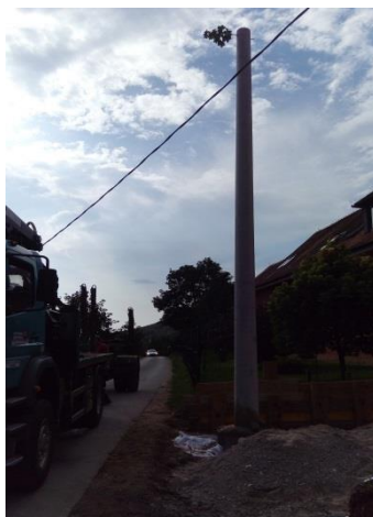
Slika 10 Postavitev betonskega droga Lastni vir
