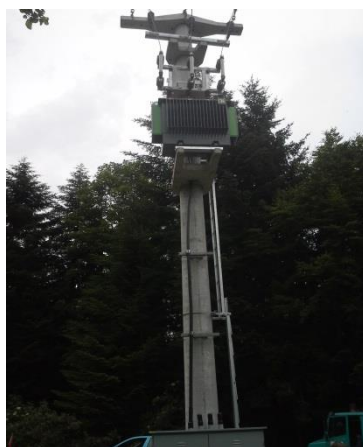
Slika 9 TP na betonskem drogu Lastni vir
