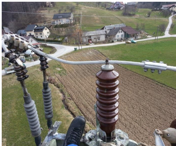
Slika 14 Porcelanasti prenapetostni odvodnik Lastni vir
