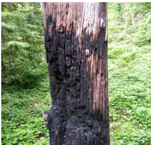
Slika 18 Od strele poškodovan nosilni drog
