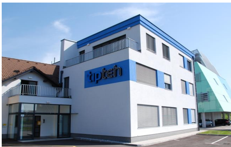
Slika 1: Poslovna stavba podjetja Tipteh d.o.o.
