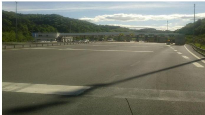
Slika 7: Prečne označbe vozne površine (Vir: Lasten)
