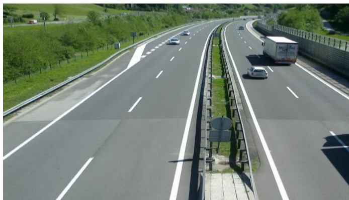
Slika 6: Vzdolžne označbe vozne površine (Vir: Lasten)
