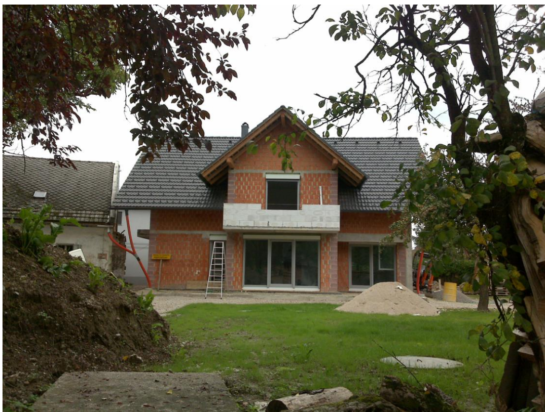
Slika 3: Končana III. gradbena faza (lasten vir)
