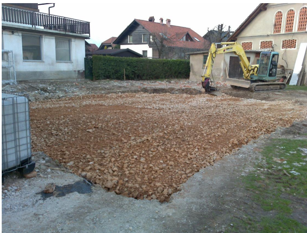
Slika 2: Utrditev terena (lasten vir)
