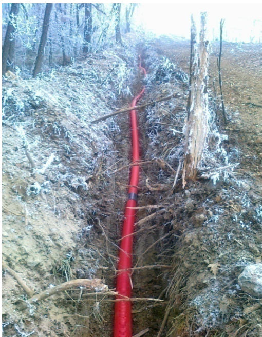
Slika 12: Polaganje kabla v cevi (Vir lasten)
