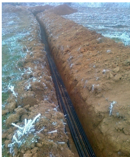
Slika 11: Polaganje kabla prosto v zemljo (Vir lasten)
