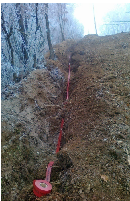
Slika 14: Položen kabel z opozorilnim trakom (Vir lasten)
