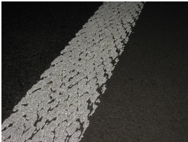
Slika 7: Primer rebraste talne označbe, izdelane iz vroče plastike (Vir: lastni)
