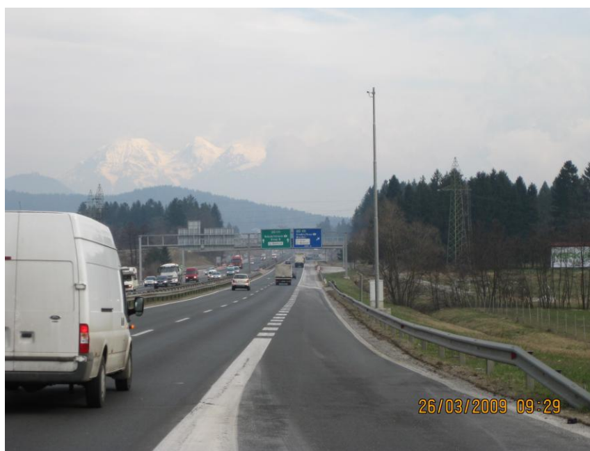
Slika 25: Prekratek pospeševalni pas
