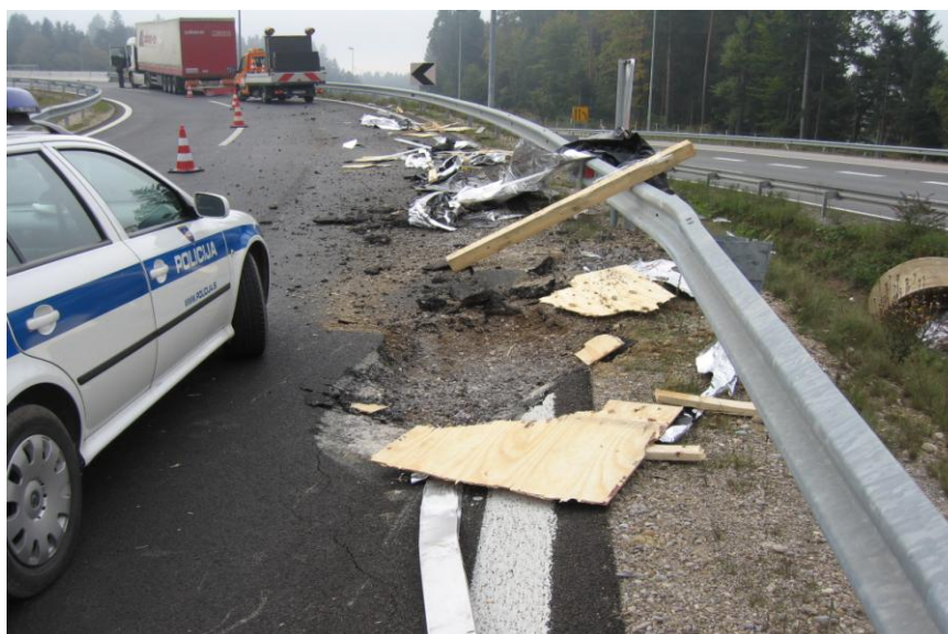
Slika 8: Poškodba vozišča ob izpadu tovora
