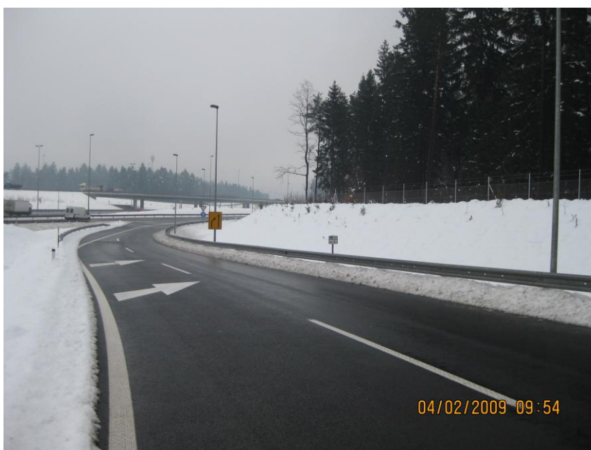
Slika 13: Zaključek dveh pasov pri stacionaži odseka km 0,5
