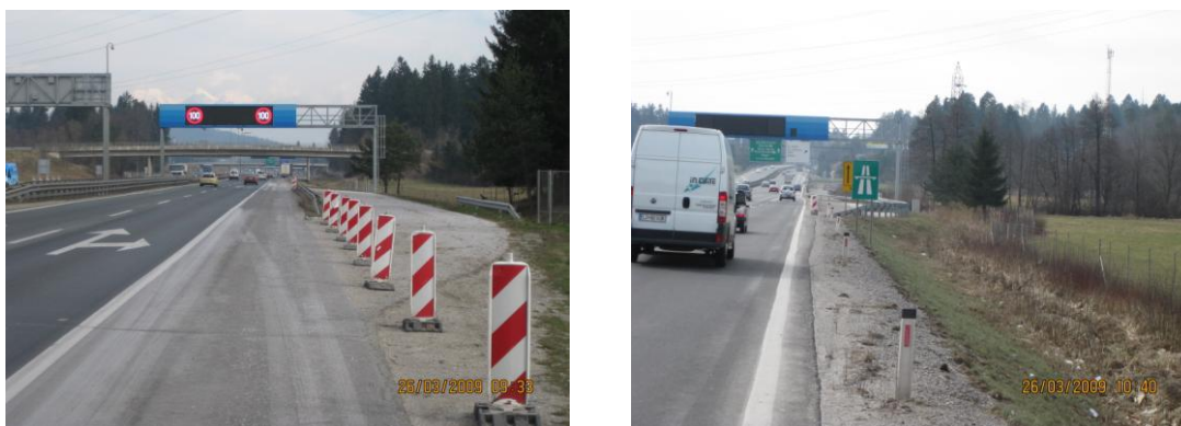
Slika 28: Obstoječi zaprti niši
