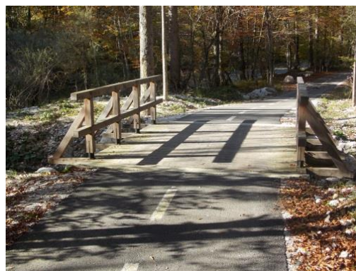
Slika 38: Premostitveni objekt čez hudournik v Grabnah Vir: Lasten (21. 10. 2012)
