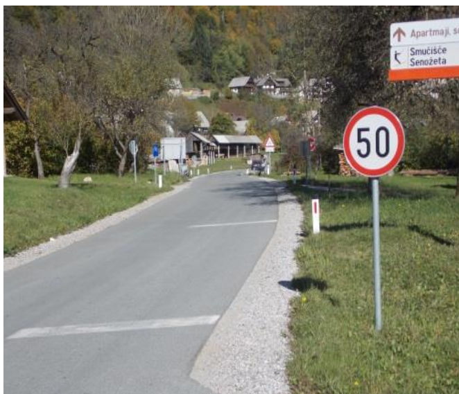
Slika 45: Vertikalna in horizontalna signalizacija opozarjata na zmanjšanje hitrosti pred mostom čez Vrčico
