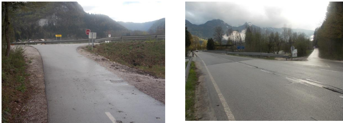
Slika 20: Vstopna točka z regionalne ceste pri savskem mostu Vir: Lasten (28. 4. 2013)
