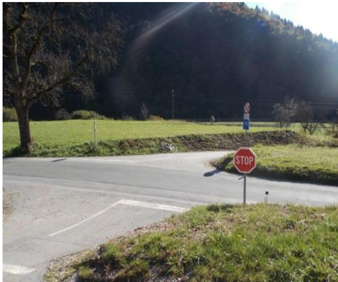
Slika 44: Brežina zmanjšuje preglednost kolesarjem na kolesarski povezavi in motornim vozilom na regionalni cesti.
