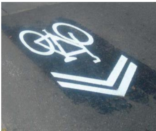
Slika 31: »Sharrows« – talna označba za vodenje kolesarjev skupaj z motornim prometom
