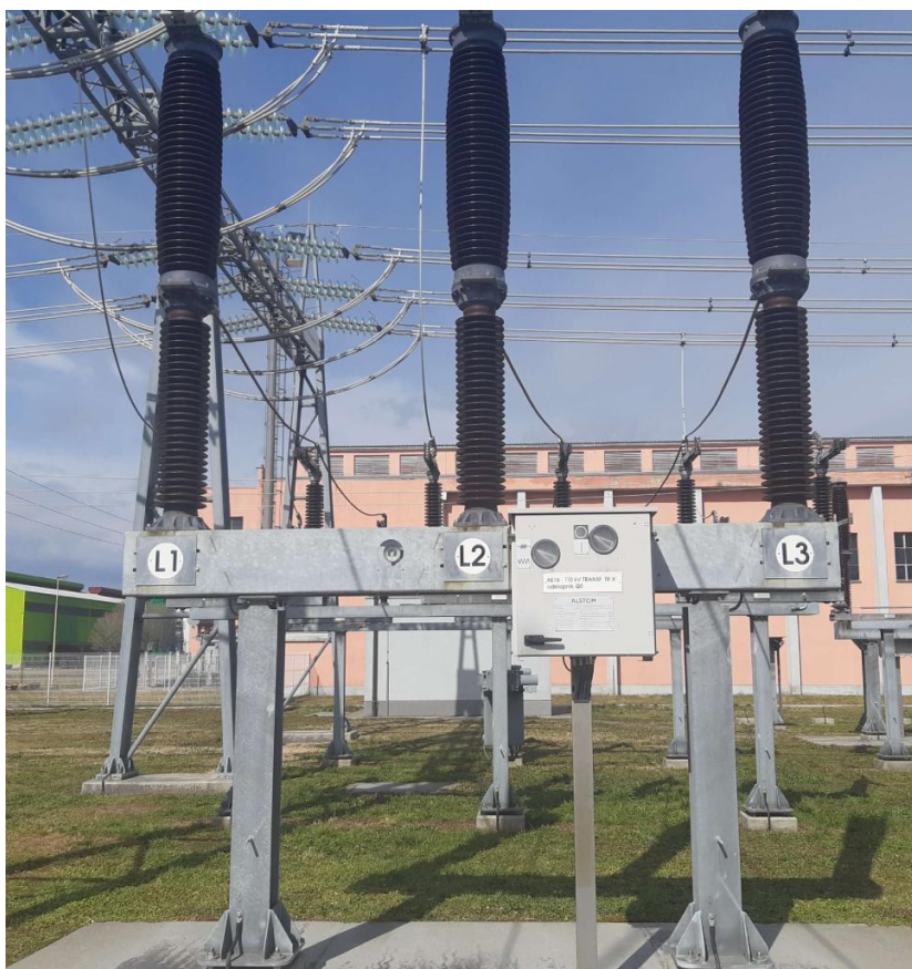
Slika 2: Visoko napetostni odklopnik 110 kV (vir: lasten)
