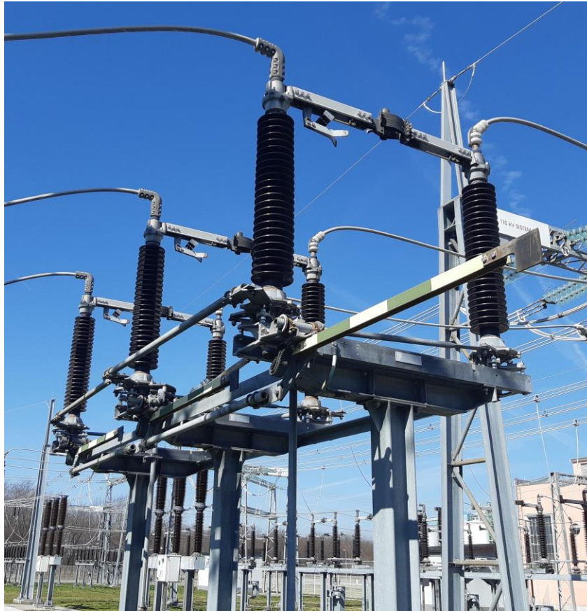
Slika 4: Ločilnik z ozemljitvenimi noži (vir: lasten)
