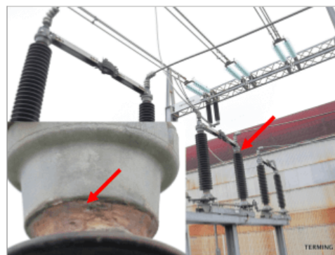
Slika 11: Korona na podpornem izolatorju
