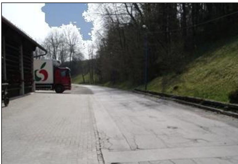
Slika 20: Nevarni del poti do podružnične šole na Drenovem Griču (Vir: lastni)
