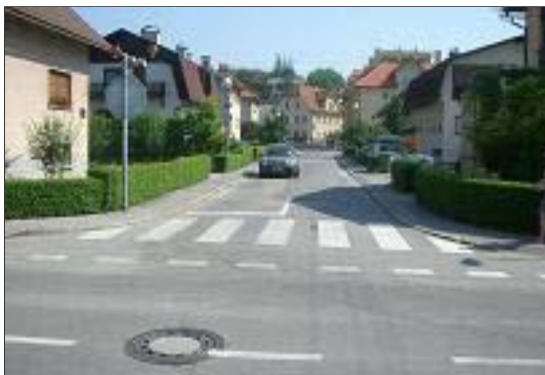
Slika 18: Nezaznavnost križišča Cesta 6. Maja–Cesta Gradenj (Vir: Fakulteta za gradbeništvo in geodezijo, 2006)
