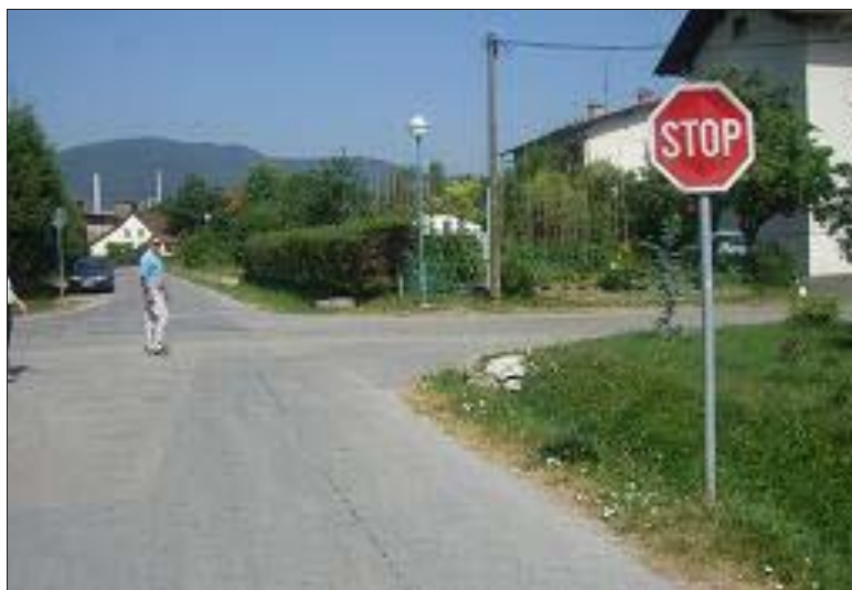
Slika 11: Pomanjkljivosti v križišču Industrija usnja Vrhnika-Mirke (Vir: Fakulteta za gradbeništvo in geodezijo, 2006)
