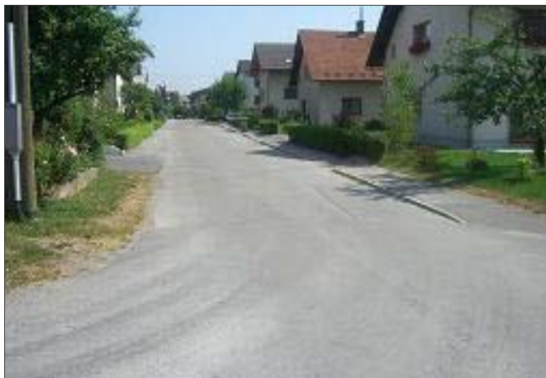
Slika 14: Pomanjkljivosti v križišču Industrija usnja Vrhnika-Mirke (Vir: Fakulteta za gradbeništvo in geodezijo, 2006)
