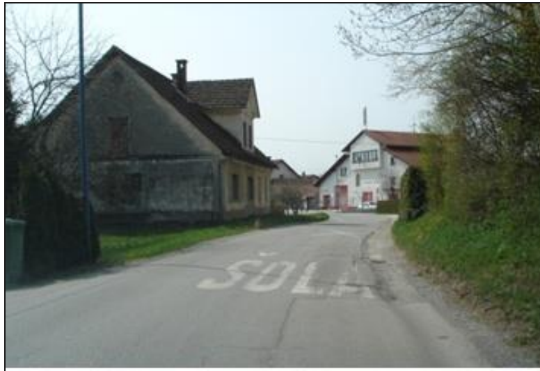
Slika 21: Nevarni del poti do podružnične šole na Drenovem Griču (Vir: lastni)
