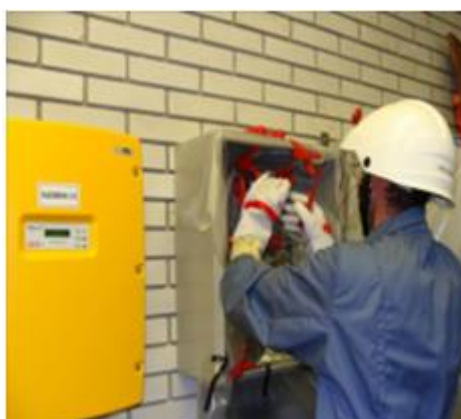
Slika 26: Primer vgradnje odvodnika prednapetosti z DPN Vir: Agencija Poti d.o.o. 2018) 16
