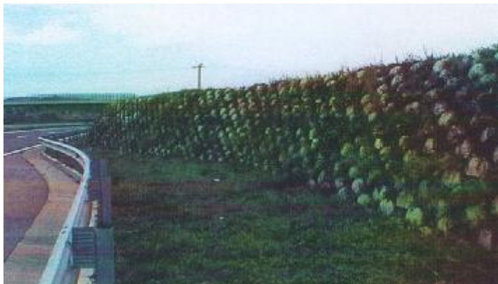
Slika 34: Nasip, obložen z betonskimi oblikovanci
