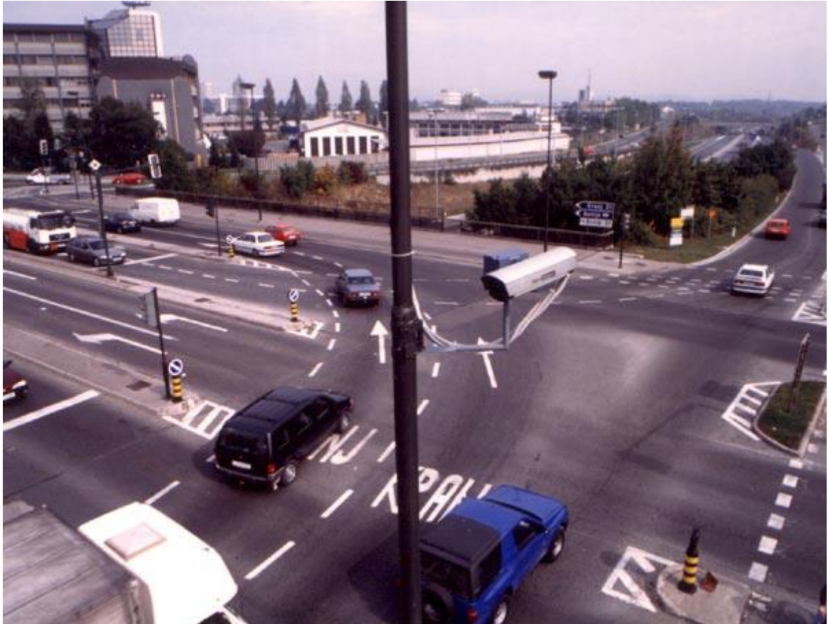
Slika 13: Videonadzor prometa na križišču
