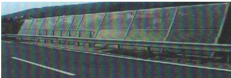
Slika 32: Protihrupna ograja iz poliakrilnega stekla
