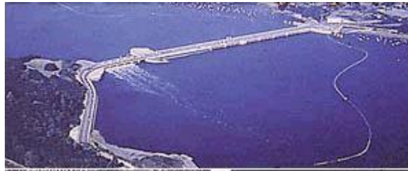
Slika 19: Primer pregrajenega zaliva obratujoče elektrarne v Franciji Pregrada povezuje obe strani zaliva. ( http://popularmechnics.com/popmech/sci/tech/9712TUENTM.html )
