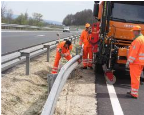
Fotografija 8: Menjava poškodovanih jeklenih ograj Vir: Lastni
