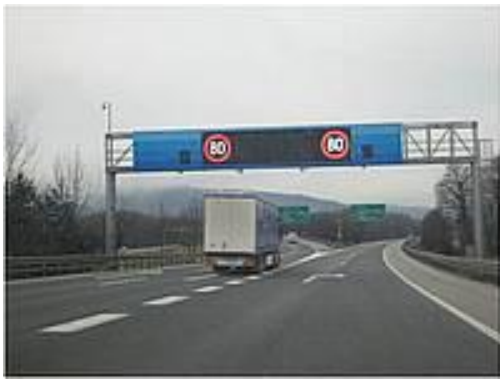
Fotografija 21: Sistem za nadzor in vodenje Vir: Internetna stran DARS d.d.
