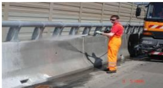
Fotografija 13: Pranje betonske varovalne ograje Vir: Lastni
