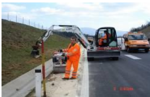
Fotografija 5: Redno vzdrževanje bankin Vir: Lastni
