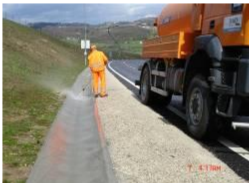
Fotografija 6: Redno vzdrževanje – odvodnjavanje Vir: Lastni
