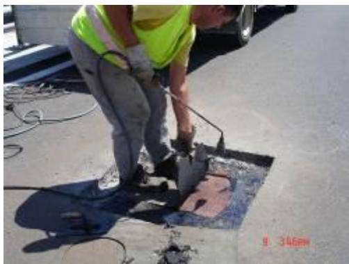
Fotografija 3: Krpanje asfaltne površine Vir: Lastni
