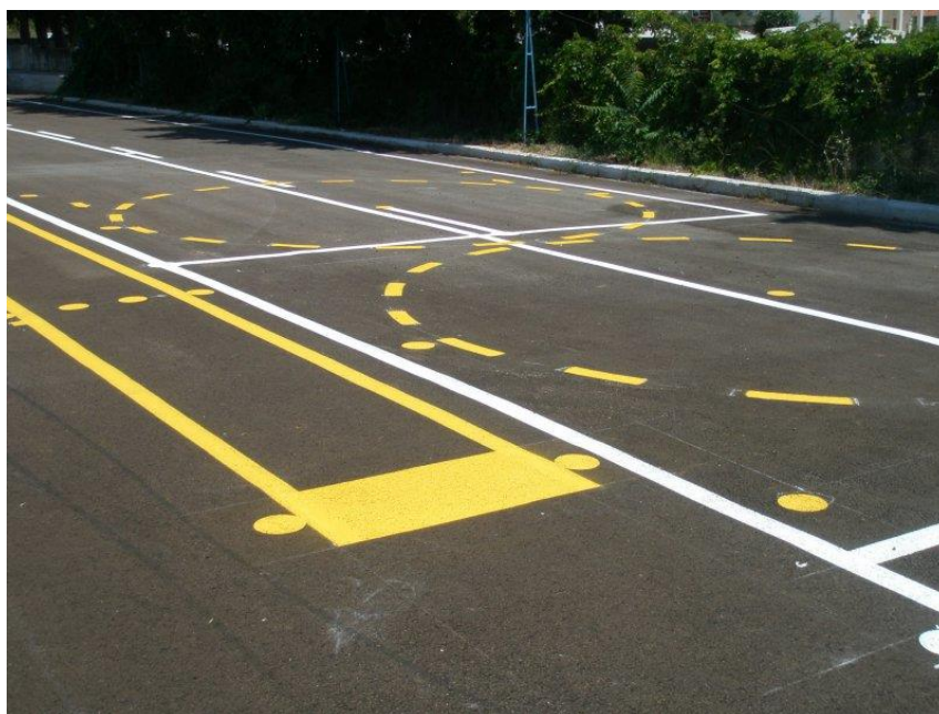
Slika 4: Horizontalna signalizacija (Vir: Prometna signalizacija, 2012)
