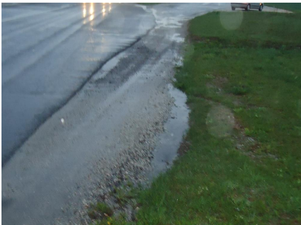
Slika 15: Cestišče pred odsekom (Lastni vir)
