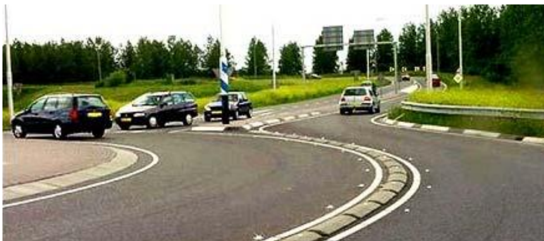
Slika 34: Elementi, ki ločujejo vozne pasove (delineatorji) v turbo – krožnem križišču (Vir: http://www.imob.uhasselt.be/var/files/misc/Donne+Pres+Omgaan+met+Ruimte.pdf , 2008)
