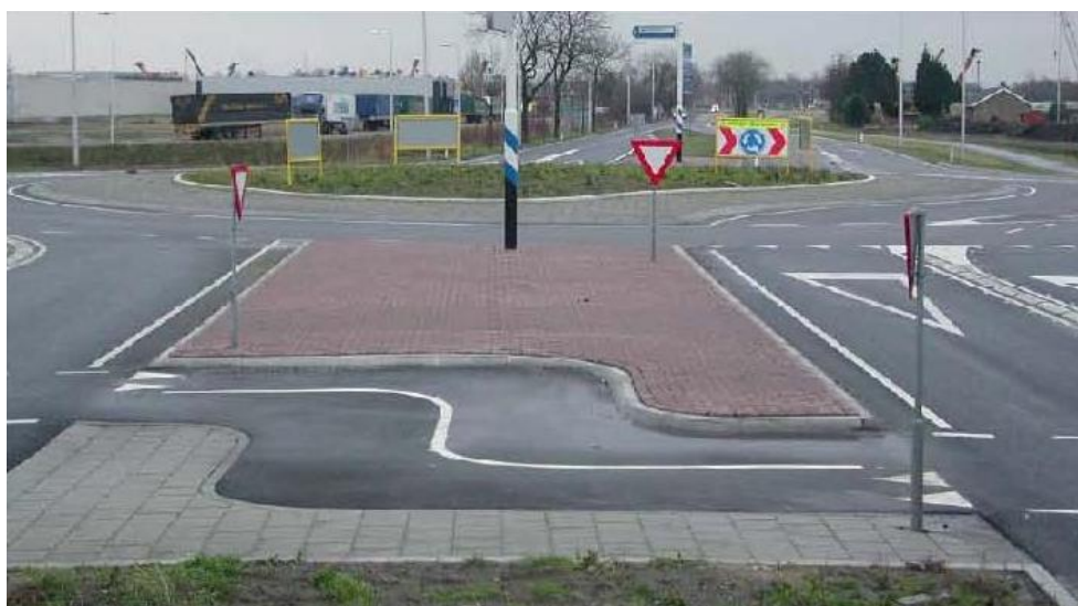
Slika 41: Prehod za pešce in kolesarje (Fortuijn, 2003) (Vir: Tomaž Tollazzi, Zgodovina krožnih križišč na slovenskem in "novi val" krožnih križišč, 2008)
