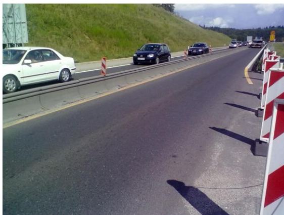
Slika 28: Mini guard na avtocestnem odseku, ki je še v gradnji, pred viaduktom Peračica
