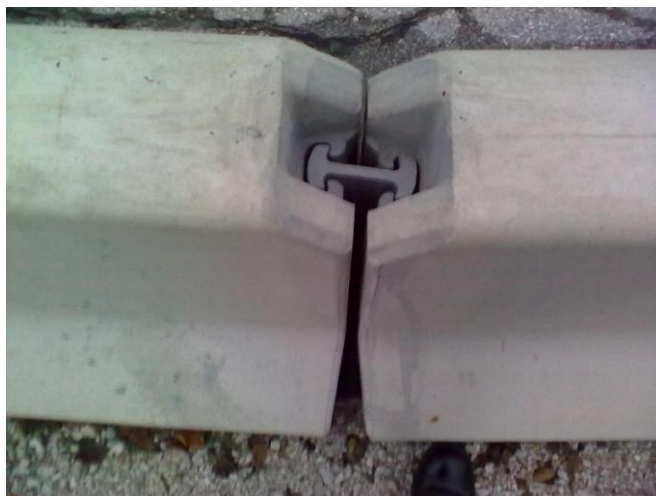
Slika 24: Primer spojitve dveh komponent BVO
