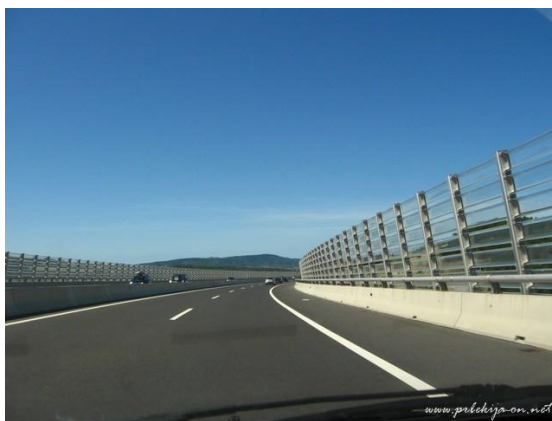
Slika 35: Protivetrna ograja na viaduktu Črni kal, kjer lahko piha burja s sunki tudi do 160 km/h
