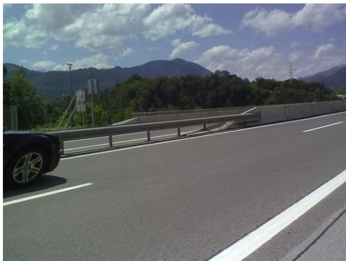
Slika 26: Primer jeklene varnostne ograje, ki preide v betonsko varovalno ograjo
