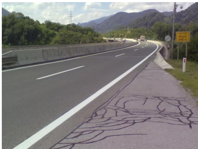
Slika 23: Primer betonske varnostne ograje na avtocesti A2, viadukt Moste
