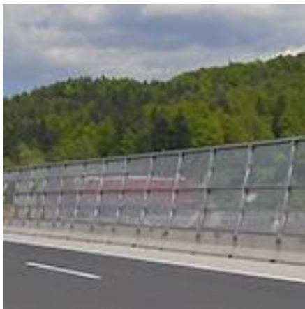
Slika 38: Transparentna protihrupna ograja
