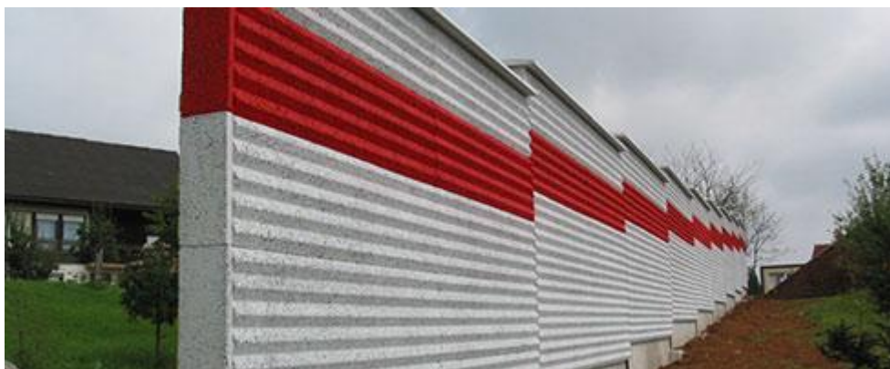
Slika 37: Lesocementna protihrupna ograja
