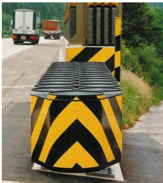
Slika 30: Primer cestnega blažilca trka
