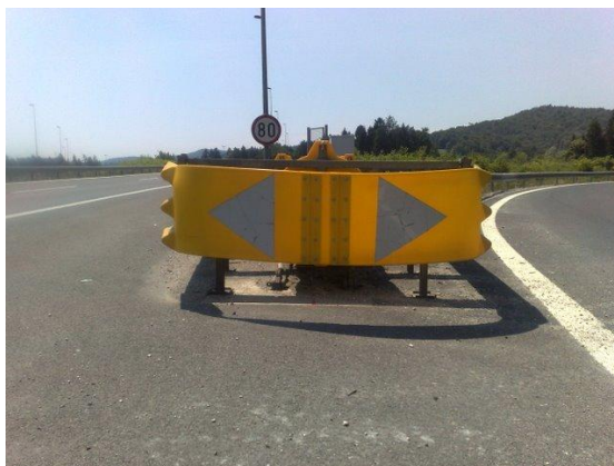
Slika 29: Primer naletnega meha oziroma cestnega blažilca trka
