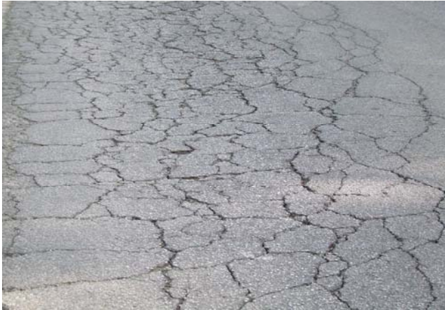
Slika 6: Vpliv soli na vozišče (Vir: Lastni posnetek, 2007)
