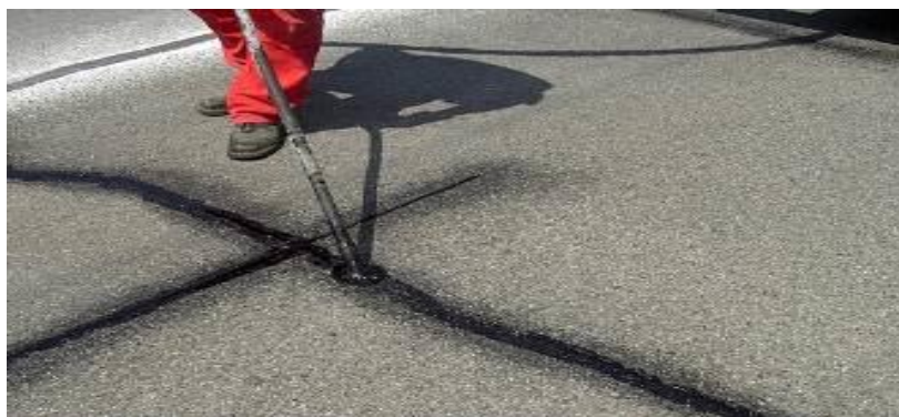
Slika 3: Sanacija razpoke (Vir: Possehl posebne gradnje, 2017)
