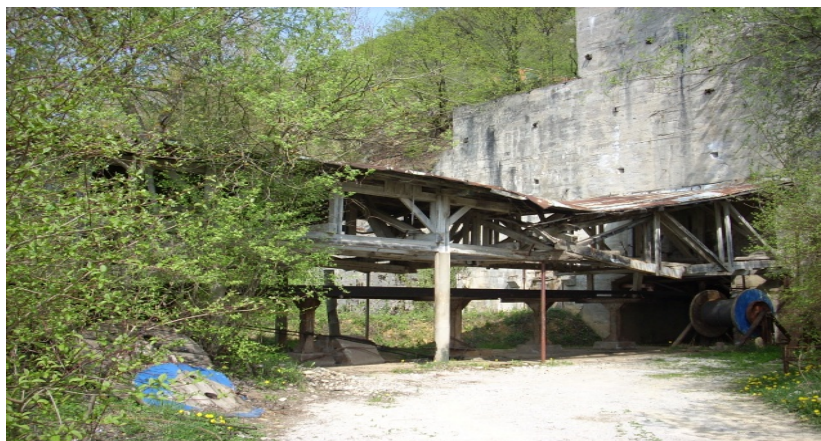
Slika 9: Zgornja postaja – pogled na kolot vrvi za menjavo vrvi na trasi
