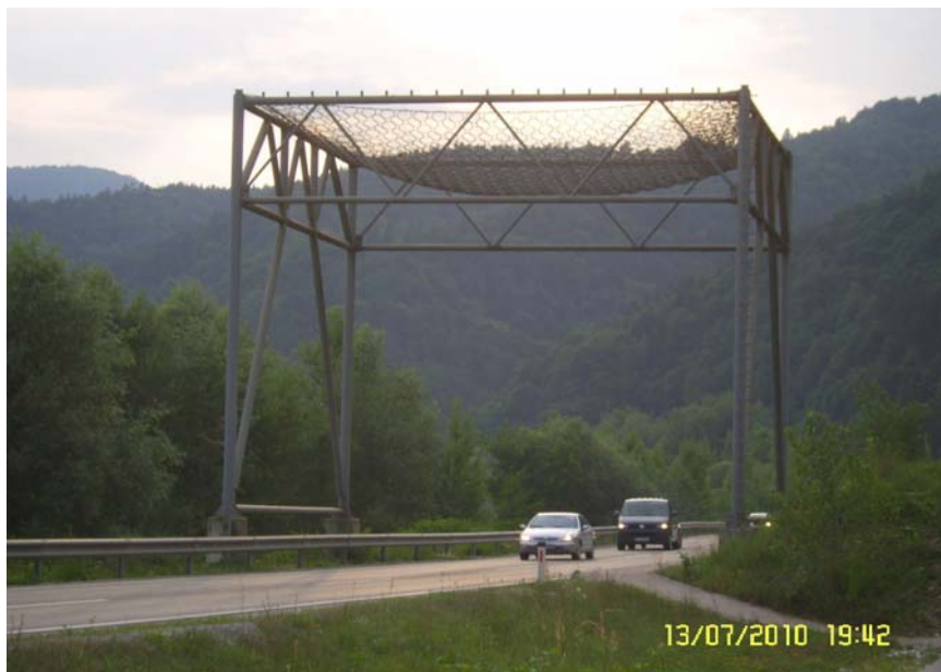
Slika 7: Zaščita nad cesto zaradi možnosti pada kamenja iz vozička
