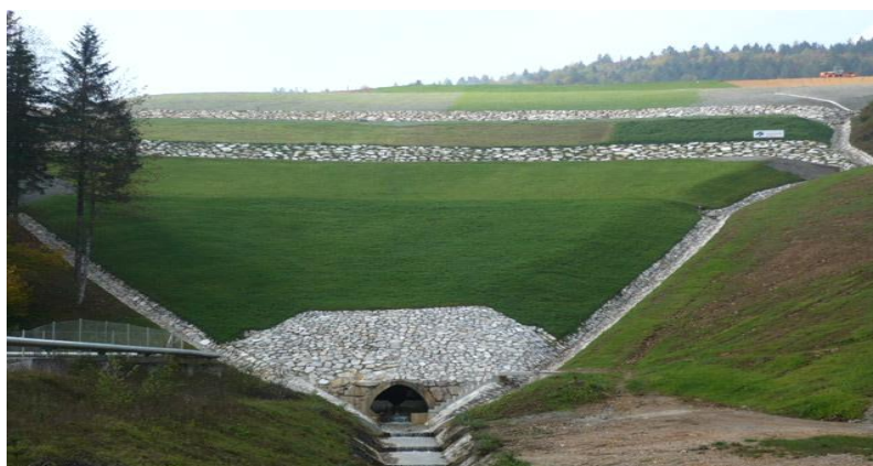
Slika 2: Sanacija jalovišča Žirovski vrh
