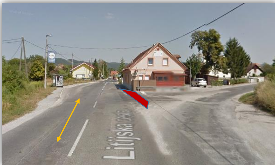
Slika 36: Križišče Litijske ceste in Ceste II. grupe odredov (Vir: https://www.google.si/maps/place/Ljubljana/ )
