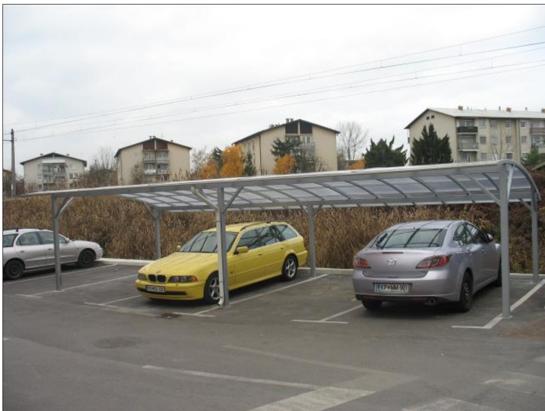
Slika 10: Sodobno parkirišče za stanovalce na Viški cesti v Ljubljani
