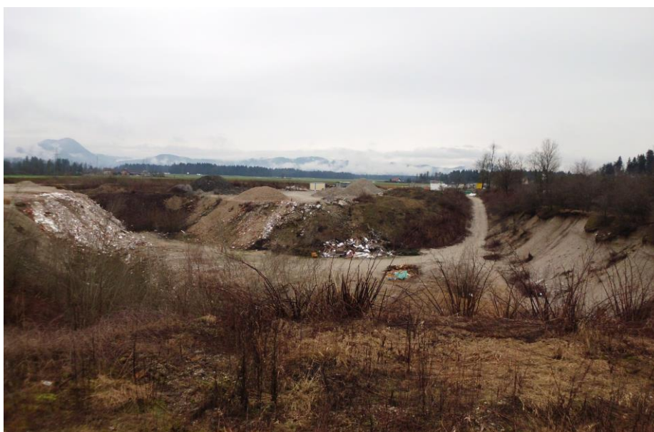
Slika 12: Deponija z gradbenim materialom (Vir: Lasten)
