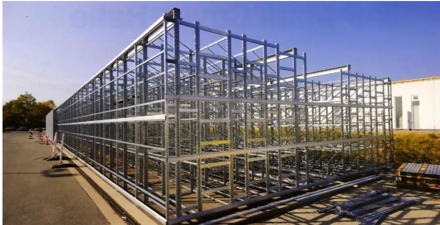
Slika 31: Regalni sestav pred zapiranjem s paneli in streho (Vir: Katalog Automotive 2012)
