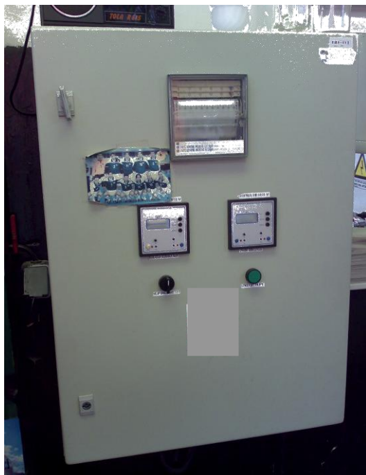
Slika 15: NEVTRALIZACIJSKA NAPRAVA
