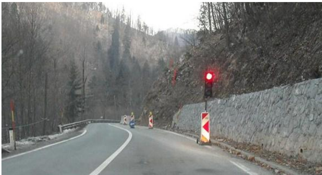
Slika 2: Pripravljala dela na izvedbo 3. voznega pasu v Zali
