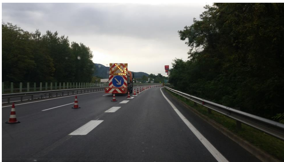
Slika 10: Signalizacija preusmeritve prometa na kontrolno točko (Vir: lastni)
