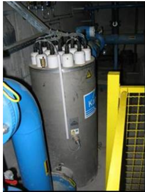
Slika 2: Ultravijolični filter (vir: A. Zupin, 2007)
