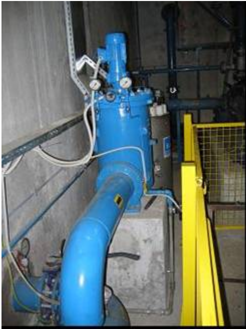
Slika 1: Mikrofilter (vir: A. Zupin, 2005)
