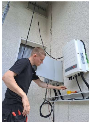
Slika 1.3: Montaža fotovoltaičnih modulov izvajalcev Elektro Požun (levo) in montaža razsmernikov in merilnega mesta (desno)
